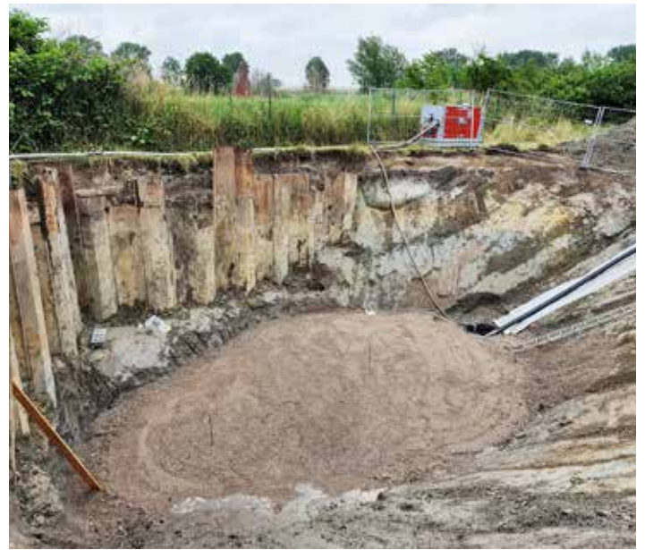
Die Baumaßnahme hat aufgrund des extrem feuchteempfindlichen Baugrundes im Mai begonnen und soll im Dezember 2020 abgeschlossen sein. Pfennigschmidt, Zweckverband Wismar
