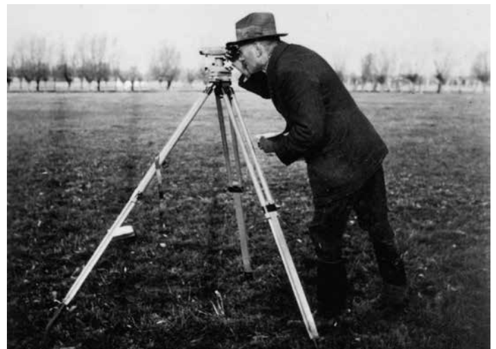
Carl Hoch bei Vermessungsarbeiten im Poeler Gelände
