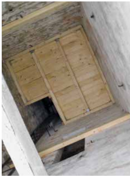
Im Turm eingebaute Zwischendecke
