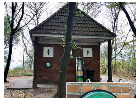
Am Schwarzen Busch – Toilette (außen)
