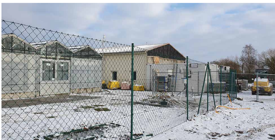
Blick auf das Baugeschehen Genbank des IPK
