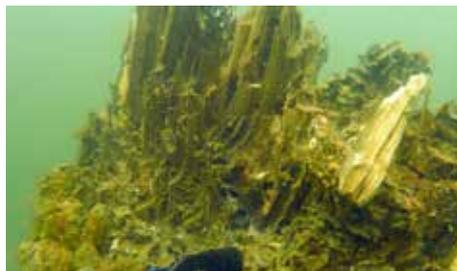
Grund (ca. 1,5 bis 2 Meter unter der Wasserlinie) abgebrochen sind. Die Pfahlbohrmuschel hat die Pfähle genau in dieser Tiefe regelrecht durchbohrt. Zur Sicherung der Liegeplätze und zur Gefahrenabwehr wurden die Pfahlstümpfe mit weißen Markierungsbällen provisorisch kenntlich gemacht. Der Austausch der Pfähle zur nächsten Saison ist zwingend erforderlich.
