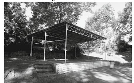
Das 80 m<sup>2</sup> große Bühnendach auf der Schlosswallanlage ist marode und muss saniert werden. Die alte Blecheindeckung soll durch
