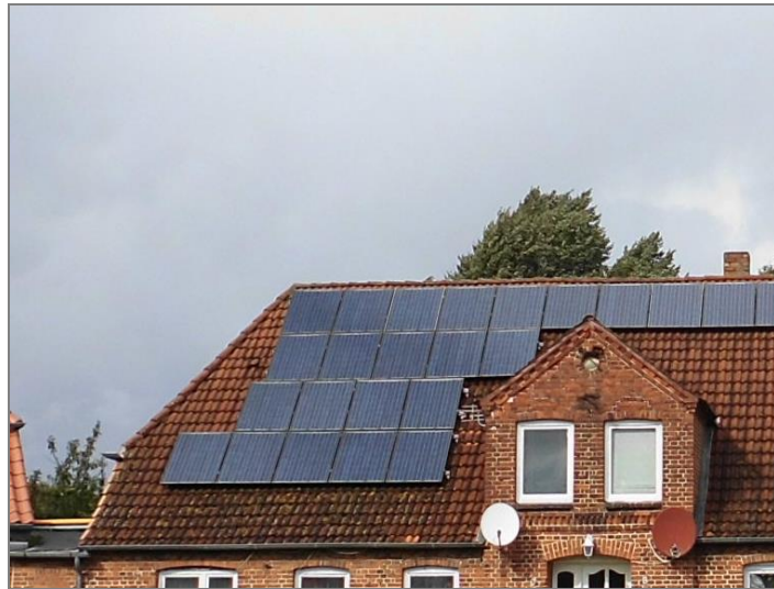
Abbildung 38: Kombination von alter Bausubstanz und Solarmodulen, Gollwitz
